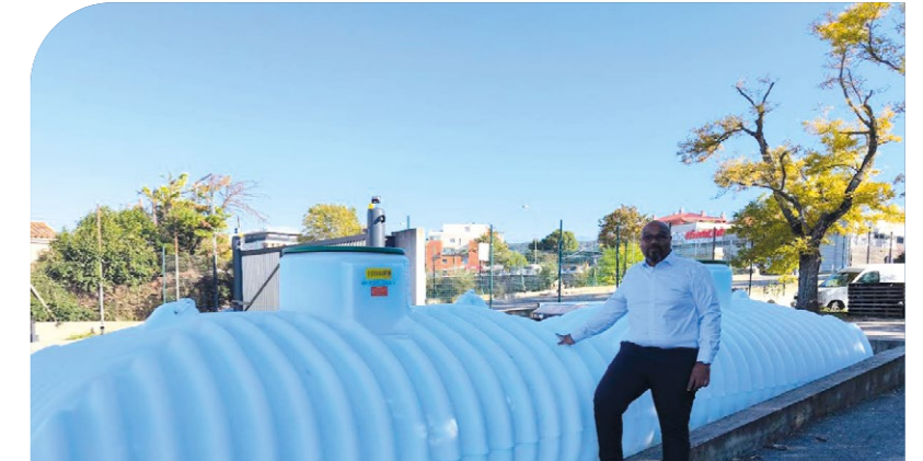
Une première innovation importée suite à cette mission : une cuve en plastique souple « grand format » commandée chez le fournisseur RICHARDSON. Cet équipement, destiné au stockage de l'eau sanitaire sur le projet « Esplanade », sera expédié en container flat, un mode de transport adapté aux équipements hors gabarit qui ne peuvent pas être contenus dans un container rigide standard.
