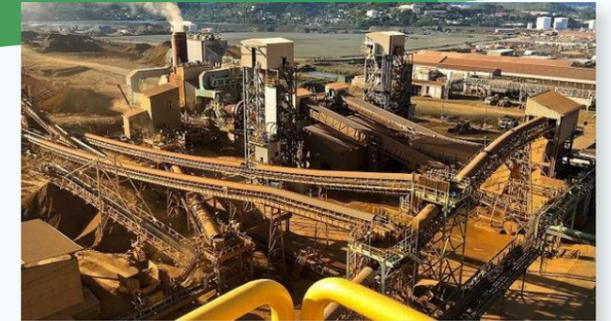
L'extraction du manganèse au Gabon se fait principalement par des méthodes d'exploitation à ciel ouvert. Les gisements de manganèse sont généralement peu profonds et relativement faciles à extraire. Le minerai est extrait à l'aide d'engins de terrassement, tels que des pelles et des chargeurs, puis transporté vers les installations de traitement.
